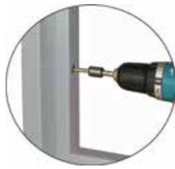
Легкий способ крепления рамы к стене
